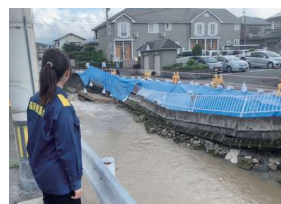
7/10 大雨が福岡を襲いました。現地調査を行いました
